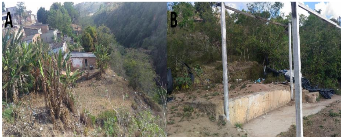
Figura 26: Ocupações no meio da encosta leste e vestígios de demolição.
