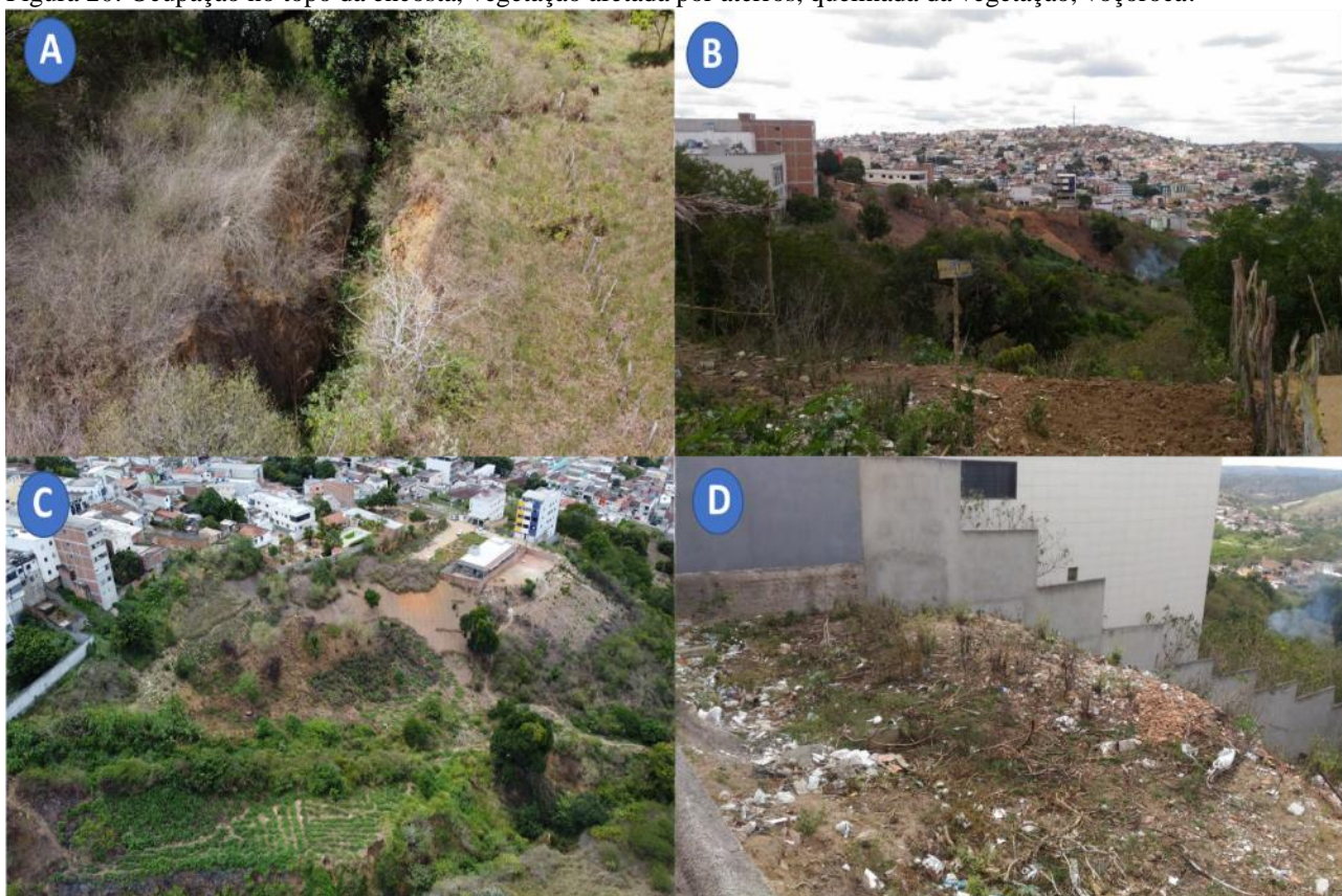
Figura 20: Ocupação no topo da encosta, vegetação afetada por aterros, queimada da vegetação, voçoroca.
